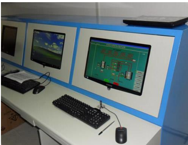
暖通空调系统远程控制、报警、监测、记录
