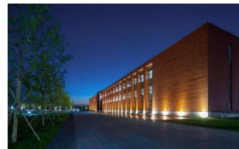
定时开关使用场所-----室外照明、景观照明
