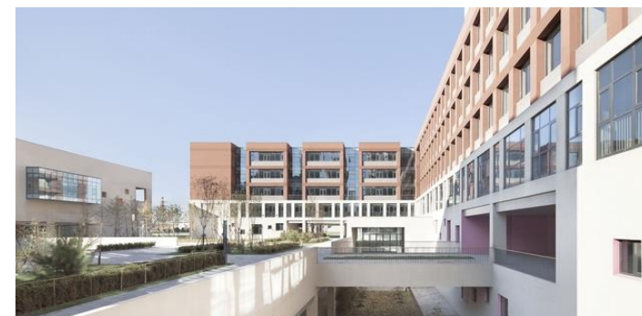
连桥及屋顶花园
